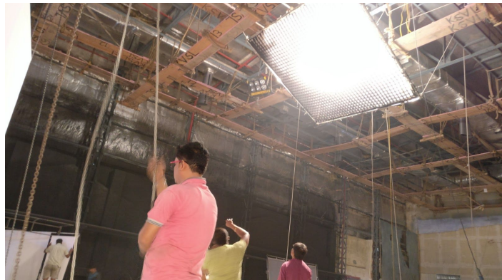
Pulling chain for LED par
